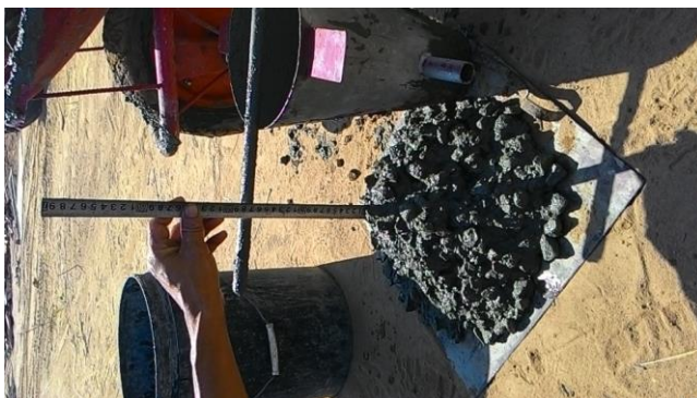
Hình 2.6: Kiểm tra độ sụt bê tông
